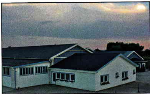
Det nya Dagcentret. Till vänster syns Snickeritillbyggnaden
